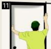
A colocação da porta deve ser feita após a instalação da fechadura e das dobradiças. Não esquecer de requare a porta com os testeiros.
